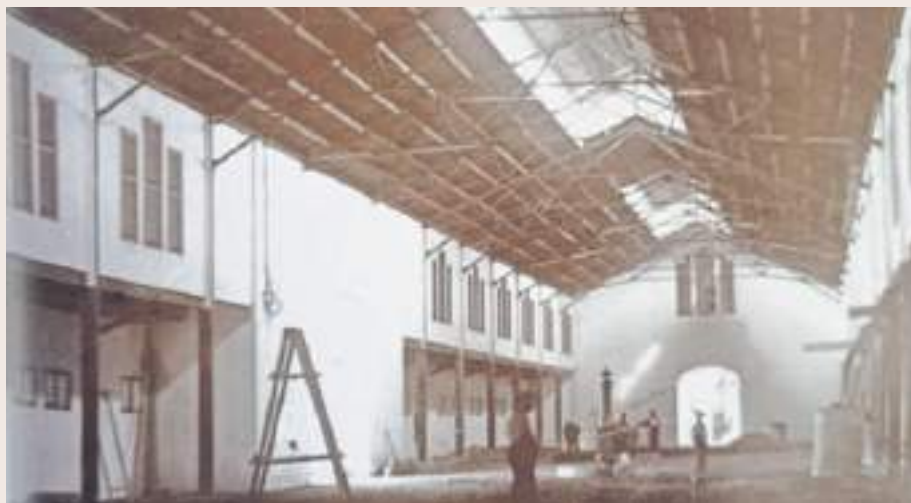
Vista de les obres de reparació de la teulada
