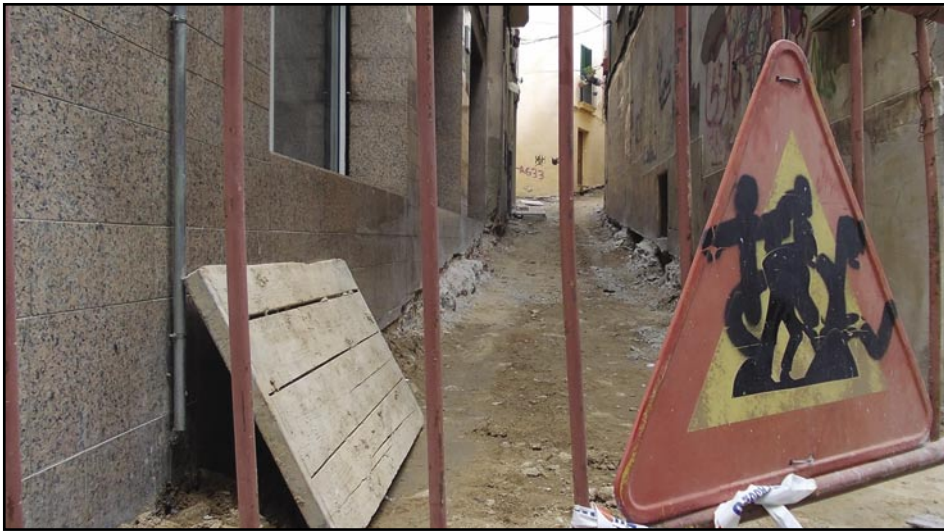
Obres al carrer al Nucli Antic
