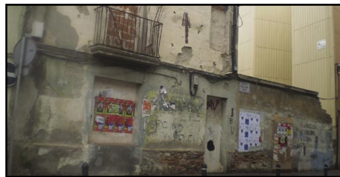
Es rehabilitaran els antics safareigs
