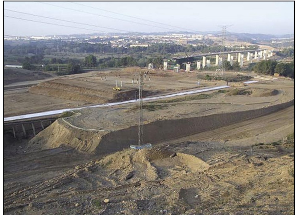
Carreteres al nostre entorn en construcció
