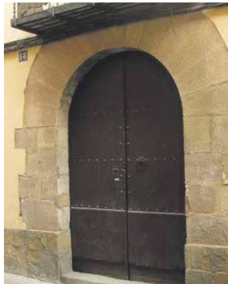
Se rehabilita Cal Puigjaner
