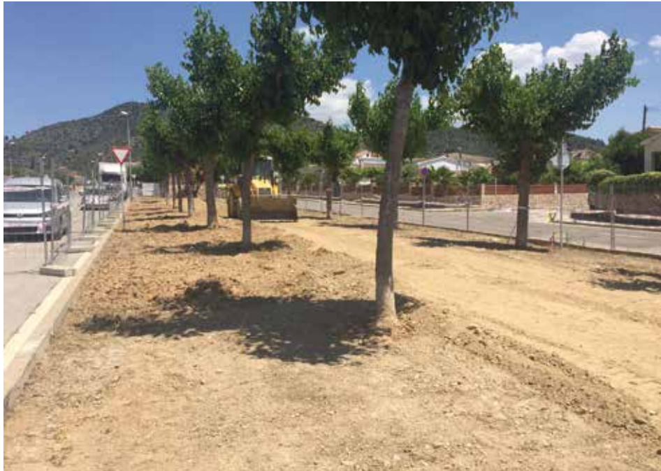
Les Planes en obres
